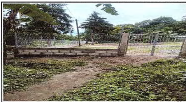
Foto 4: Vista de la puerta metálica de la entrada principal, del centro Educativo.
