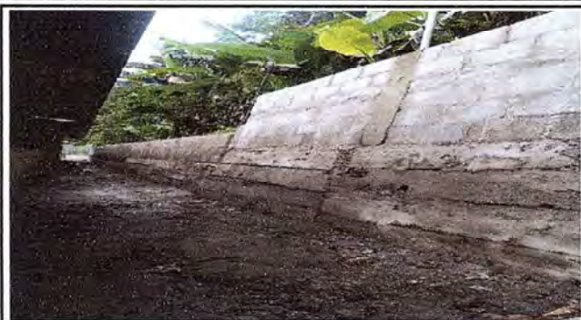
Foto 1: Se observa la finalización del muro contención.
